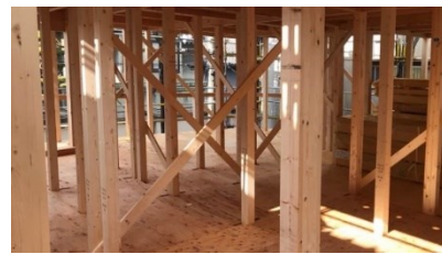
施工中の様子
